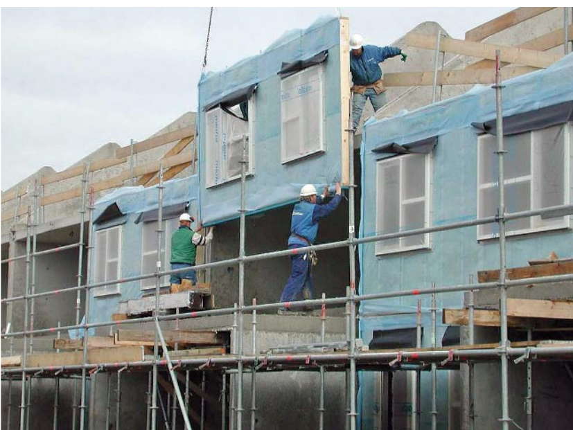
Montage houten spouwblad incl. kozijnen (links). Overzicht op rechter foto: links spouwblad met kap en rechts het casco.
