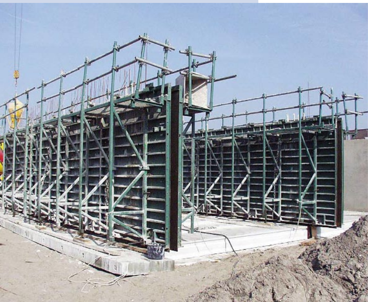
Stalen wandkist stortklaar op begane grond (links). Storten van de wanden (rechts).
